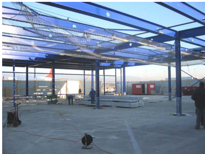
Construction de la halle de tri – contrôle des bagages
